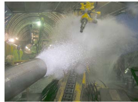
【削孔口からの噴出湧水 5t/分】
