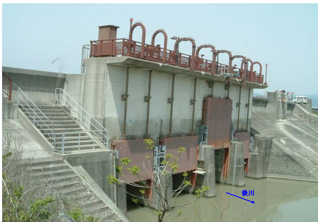
図- 3.1 後川樋門（旧施設）
