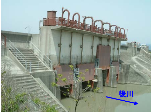
後川樋門（旧施設）
