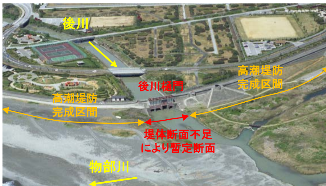
図- 4.2 物部川高潮区間（右岸）における堤防整備状況
