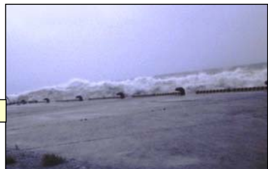
図 3.2 岸壁前面の高波の状況 (平成 16 年 9 月 台風時)
