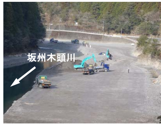
土砂除去（十二社地区）
