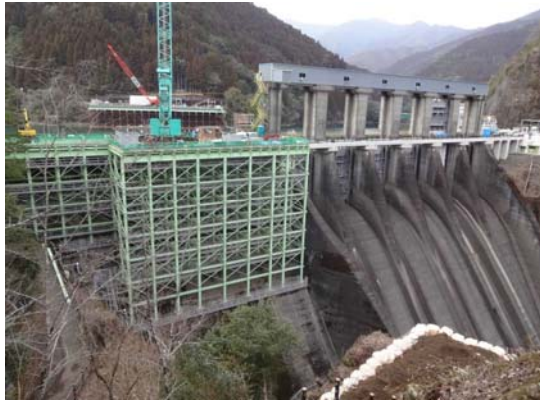
ダム天端右岸構台
