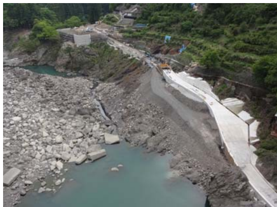
工事用道路設置
