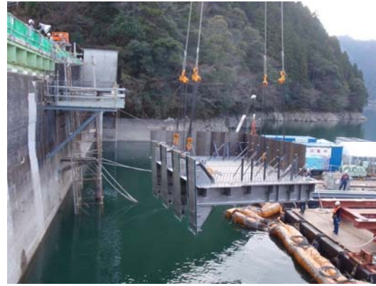
底部架台設置
