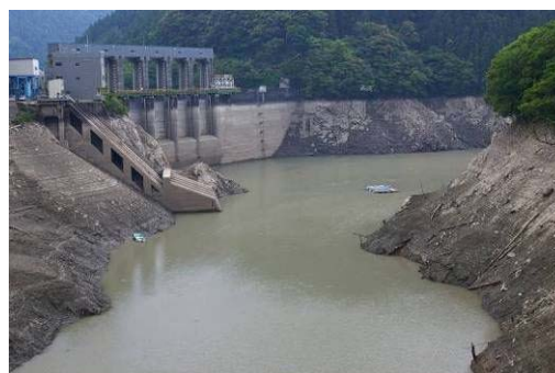
平成17年6月長安口ダムの貯水池の状況
