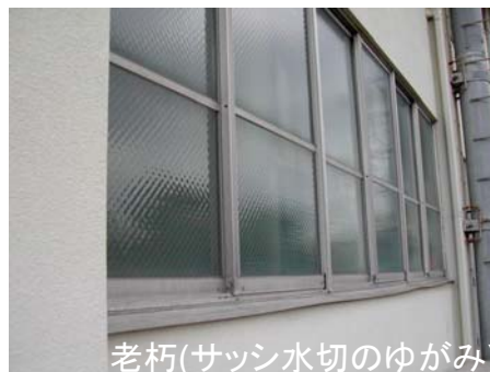
老朽(ガラス留め劣化)
