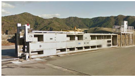
電動化陸閘の例
