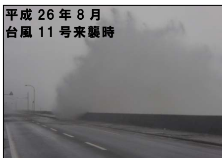
写真－ 2 激しい堤防越波（戸原工区）
