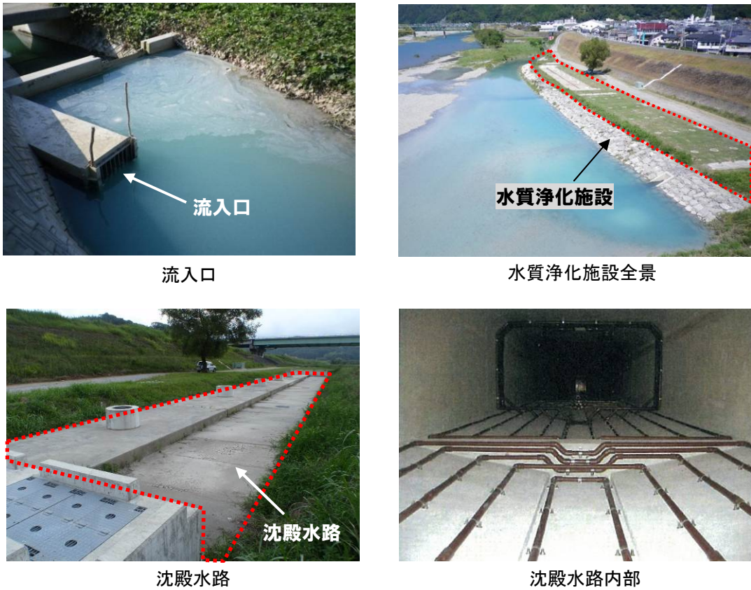
図 2. 5 水質浄化施設の状況
