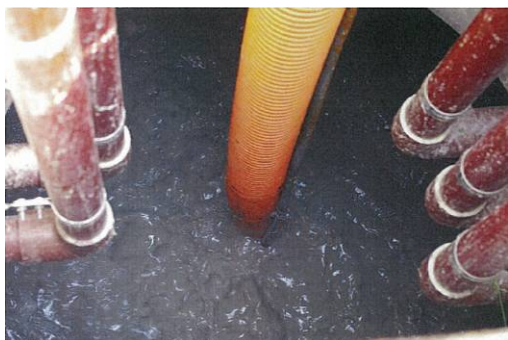
沈殿水路内の堆積物、引き抜き時は曝気攪拌
