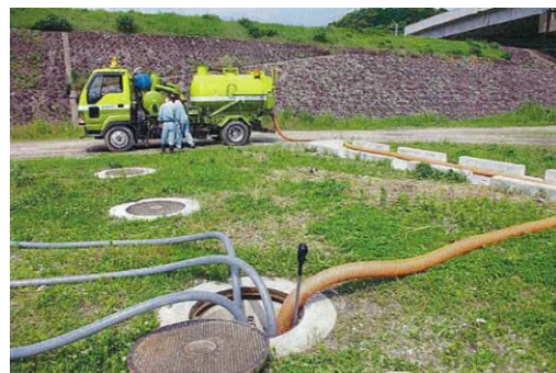
バキュームカーによる引き抜き
