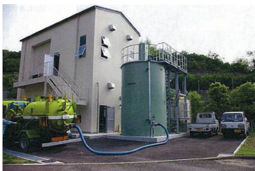
バキュームカーから貯留槽へ排出
