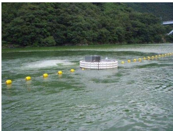
図 2.13 曝気循環装置の設置
