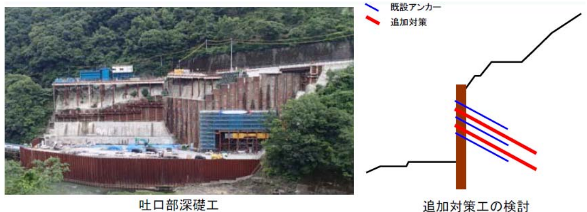
図 5.6 トンネル洪水吐き吐口部対策工の追加
