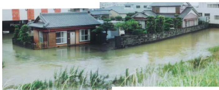
④ 桑野川左岸(阿南市宝田町川原地区)の浸水状況
