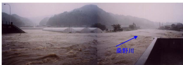
① 桑野川上流(阿南市新野町秋山地区)の越水状況
