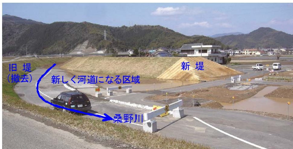
図 3.5 引堤工事实施中の様子
