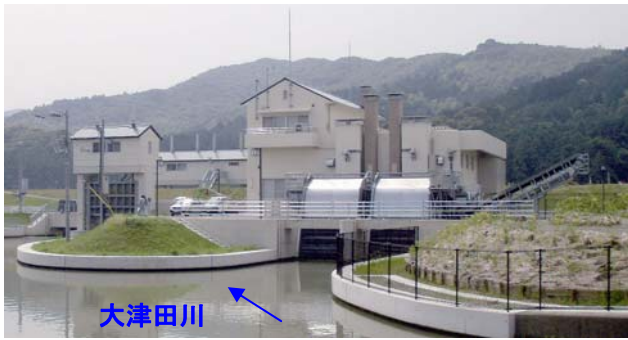
大津田排水機場（平成 20 年 2 月完成）
