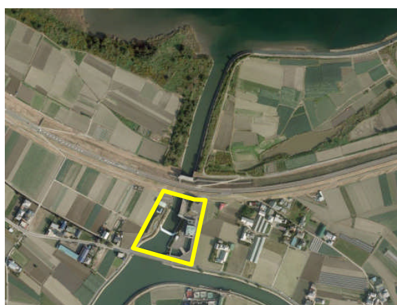
平成 24 年撮影時 (角ノ瀬排水機場完成：平成 20 年)
