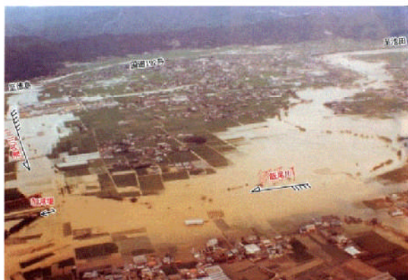
飯尾川 8k 付近（石井町）浸水状況 (S50.8 台風 6 号)
