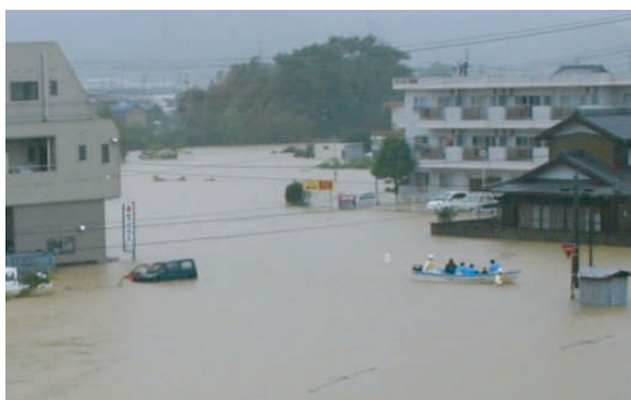
吉野川市役所前浸水状況 (H16.10 台風 23 号)
