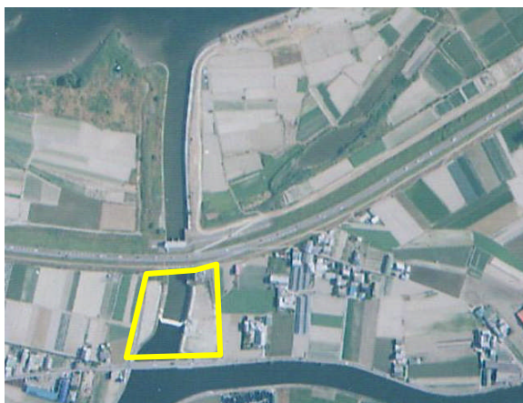
平成 17 年撮影時 (角ノ瀬排水機場着工前：平成 18 年)
