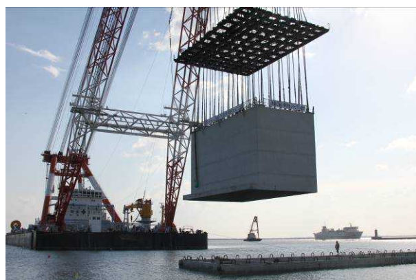
ケーソン据付状況 (撮影：H24. 12)
