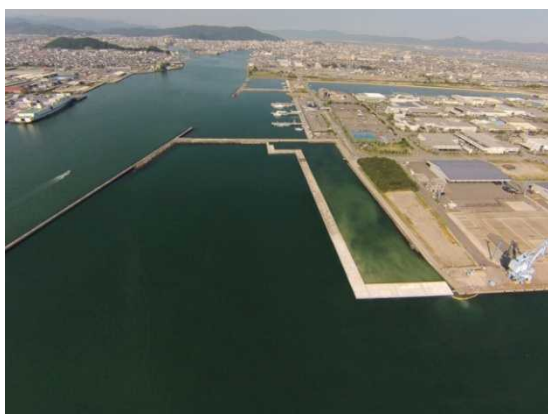
岸壁据付状況 (撮影：H25. 10)
