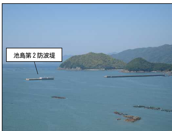
防波堤整備状況
