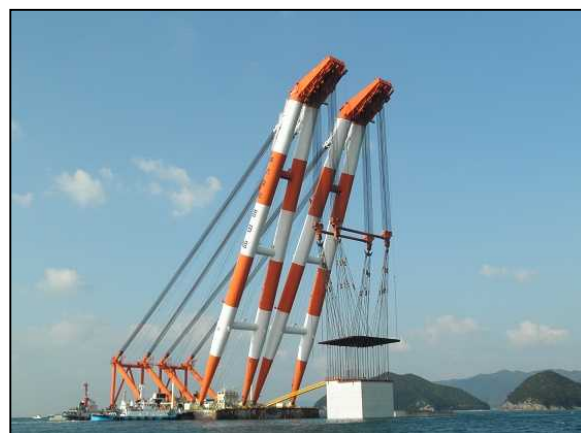
ケーソン据付状況
