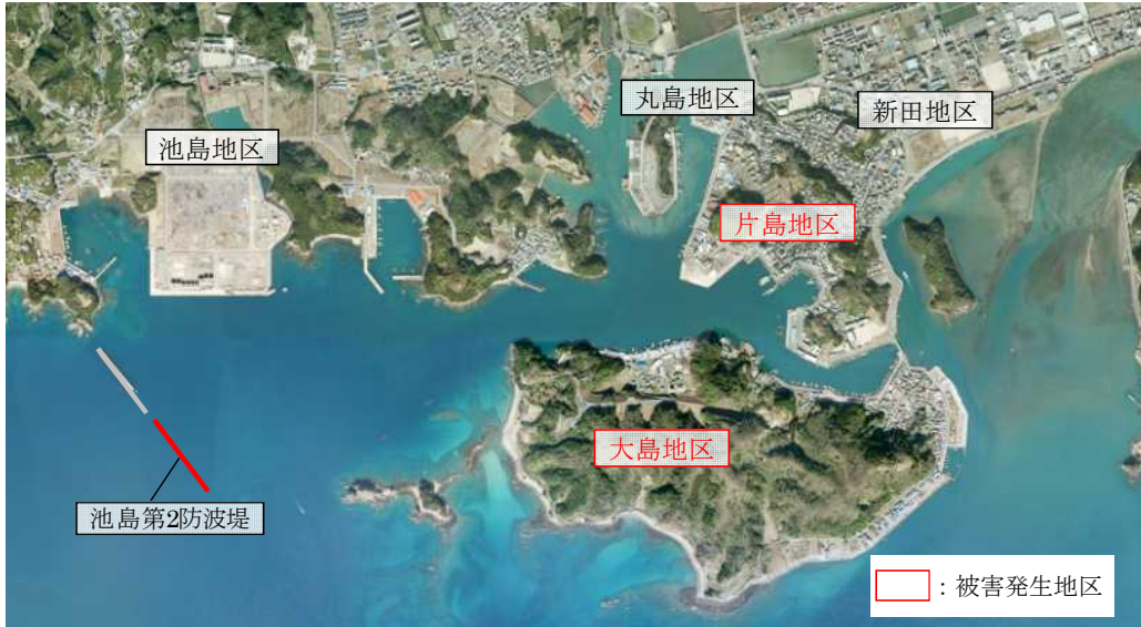
図 浸水被害発生箇所
