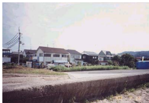
整備前の堤防の状況 (平成 13 年 7 月)
