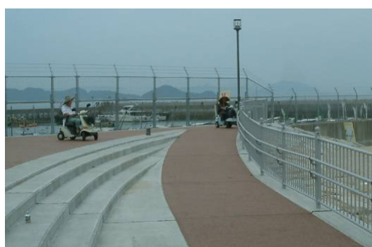
スロープの設置
