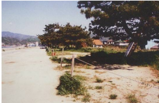
【整備前】堤防背後の松林 (平成 12 年頃)
