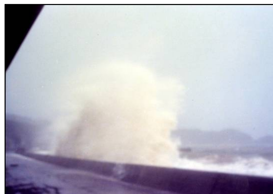
台風16号による越波状況 (昭和54年9月)
