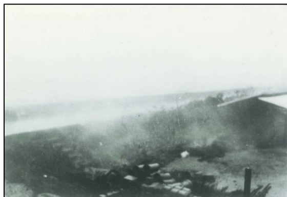
台風16号による越波状況 (昭和49年9月)
