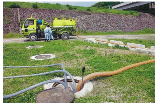
バキュームカーによる引き抜き
