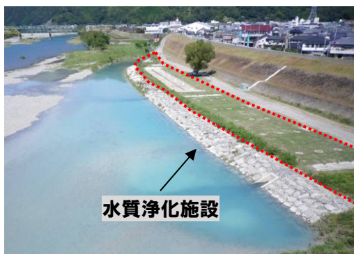
水質浄化施設
