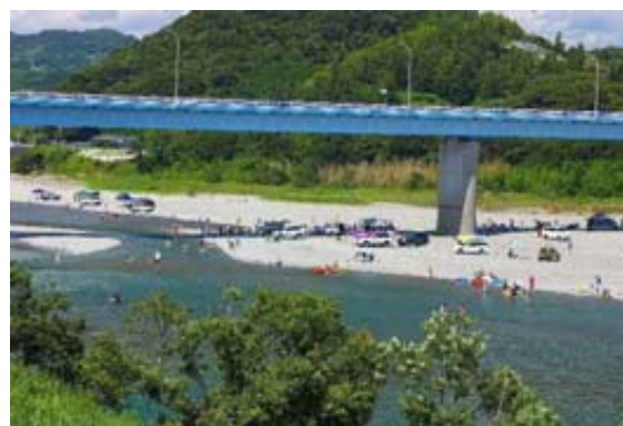
図 1. 6 水遊び (八天大橋付近)
