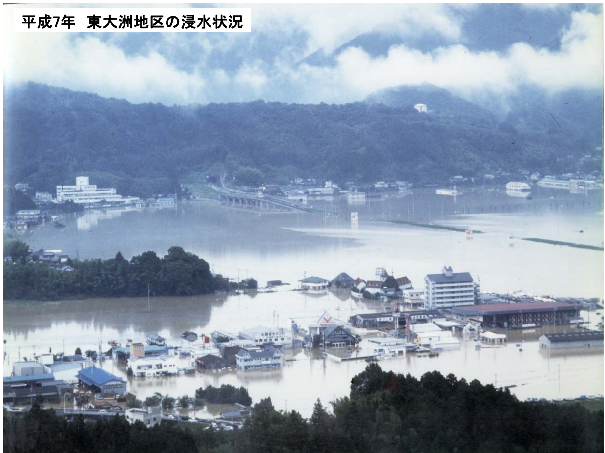
図-2.2 平成7年7月災害の浸水状況（激特事業）
