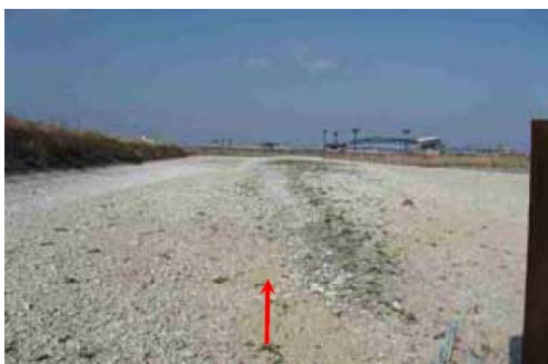
礫河原（瀬切れの状況、中川原橋付近： 【重信川河口より 5.8km 付近】）
