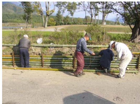
加茂第一箇所での園路補修作業
