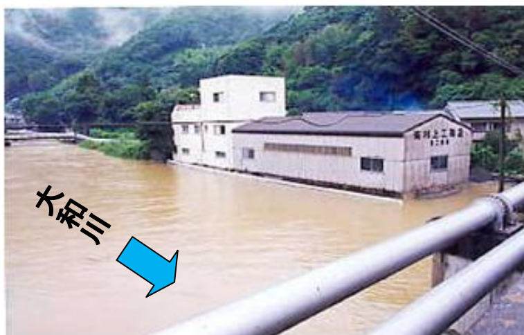
平成 7 年 7 月 梅雨前線性豪雨による浸水
