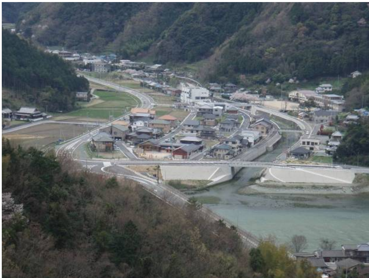
図 3.1 整備完了後の状況
