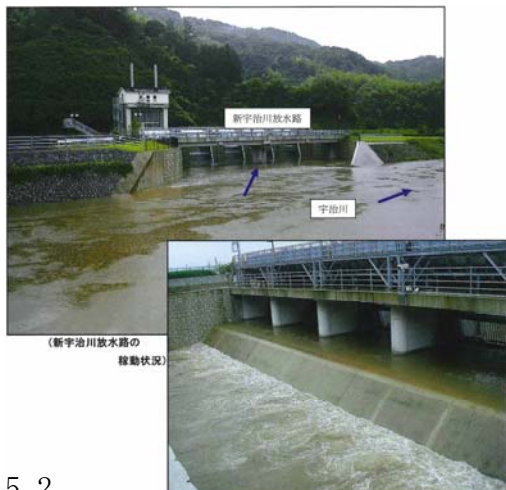
図 5.2 平成 19 年台風 4 号時の放水路稼働状況
