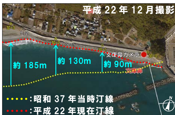
写真－1 激しい海岸侵食（仁ノ工区）
