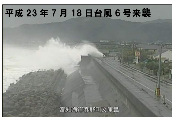
写真－3 激しい堤防越波（仁ノ工区）
