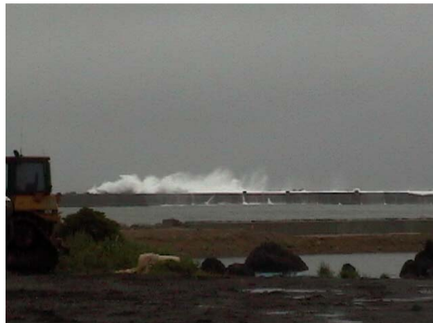
室津港における台風時の波浪状況
