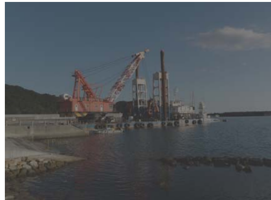
工事用船舶避難状況 (上川口港)
