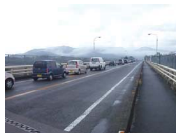
●③仁淀川大橋北詰付近
