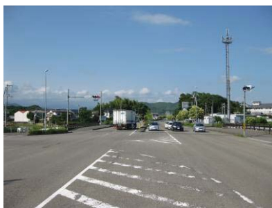
① 4車線供用区間（土佐IC入口交差点）
