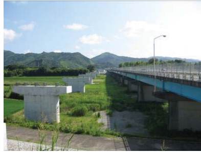
④ 事業中区間（仁淀川大橋左岸）
