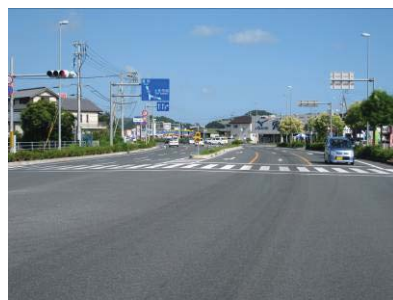
② 4車線供用区間（芝交差点）
