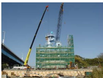
③ 事業中区間〔ニューマチックケーソン工法〕 （仁淀川大橋左岸）
