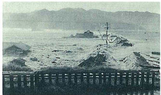
チリ地震津波被害状況(昭和 35 年)
