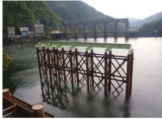
貯水池内仮設構台設置工事（設置後）
