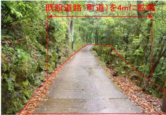
工事用道路設置
