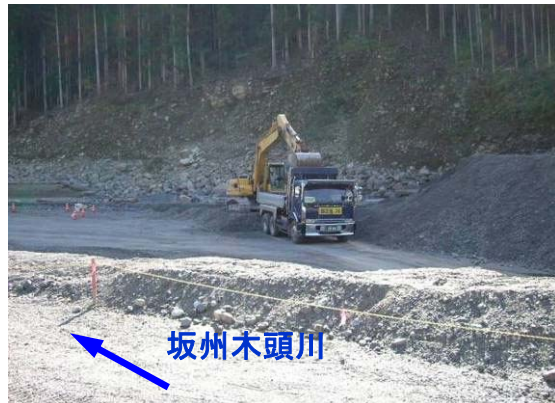
土砂除去（十二社地区）
