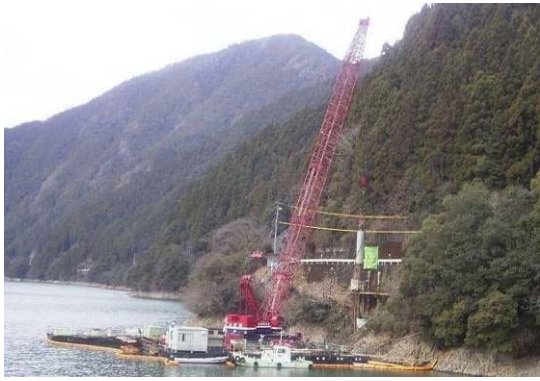
貯水池内仮設構台設置工事（施工中）
