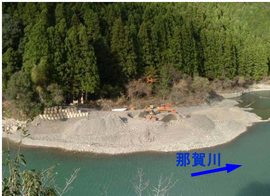
土砂除去（平谷地区）
