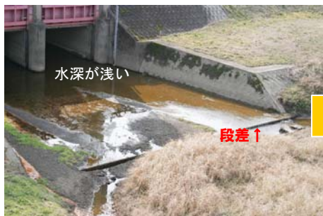
〈整備前：九樹樋門〉
