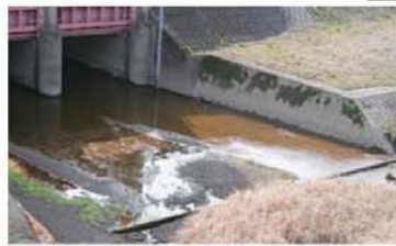
〈整備前:九樹樋門(くじゅひもん)〉
