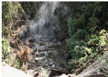
▲不安定岩塊を発破により除去
