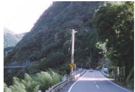
▲線形不良区間
