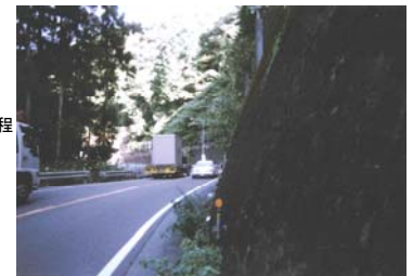
▲見通しの悪い曲線部
