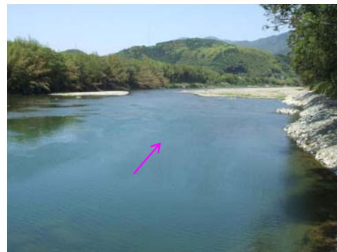
事業箇所直上流肱川河川防災ステーション前
