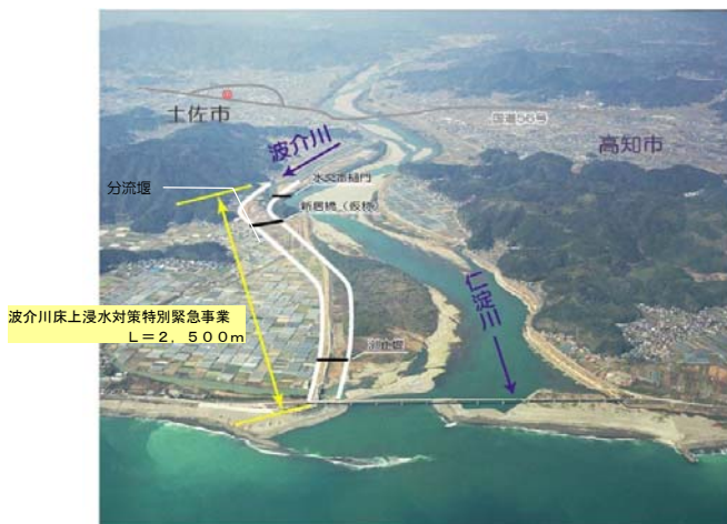
図6 波介川床上浸水対策特別緊急事業実施区間（仁淀川河口上空より望む）
