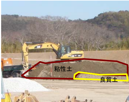
混合材の積み込み
