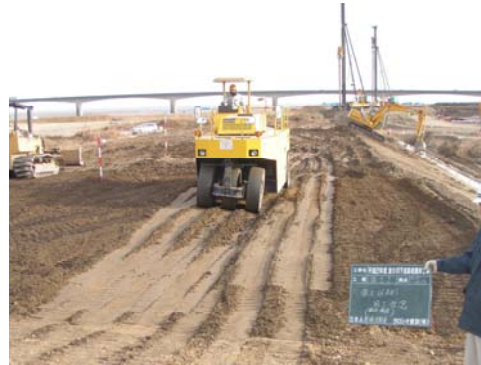
盛土施工状況
