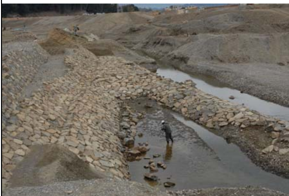
石積み護岸遺構
