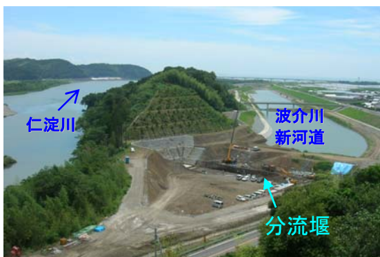
合流部より新河道を望む
