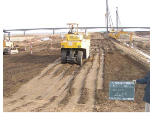
盛土施工状況
