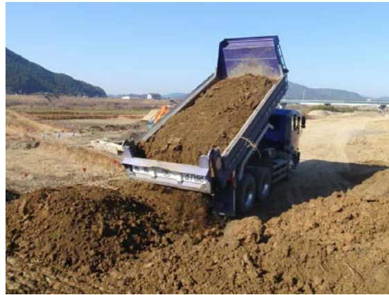
他事業で発生した建設発生土
