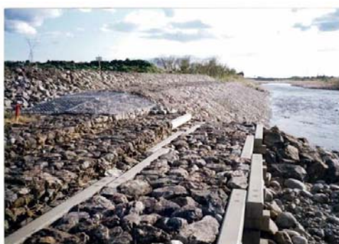
施工直後の状況
