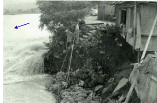
無堤地区の河岸侵食(香南市西佐古地先)
