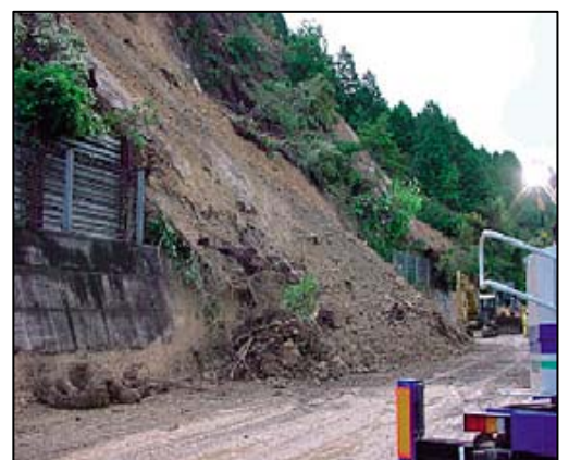
写真-5 国道11号の被害状況
