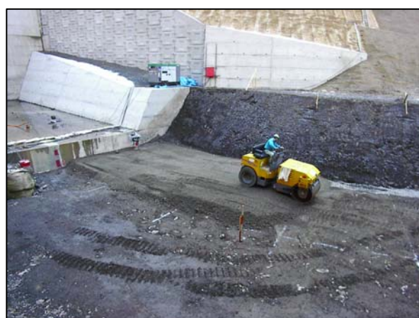
写真-11 砂防ソイルセメント施工状況写真（小松谷第2号えん堤）
