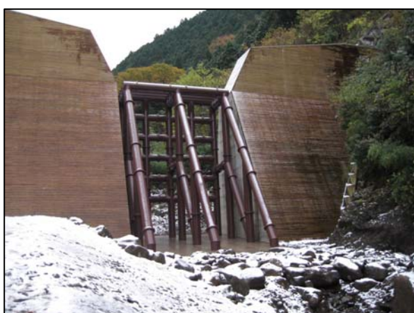
写真-10 木製残存型枠（間伐材）を用いた透過型砂防えん堤（根無谷第2号えん堤）
