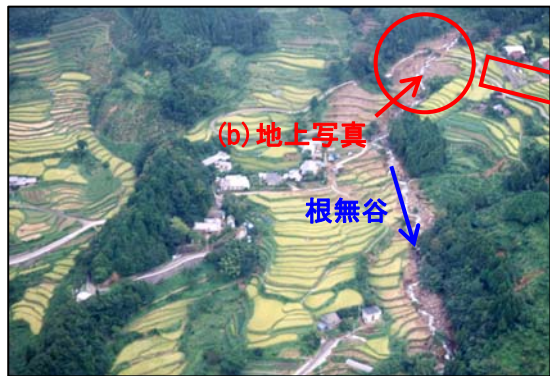
(a) 根無谷の状況 (航空写真)
