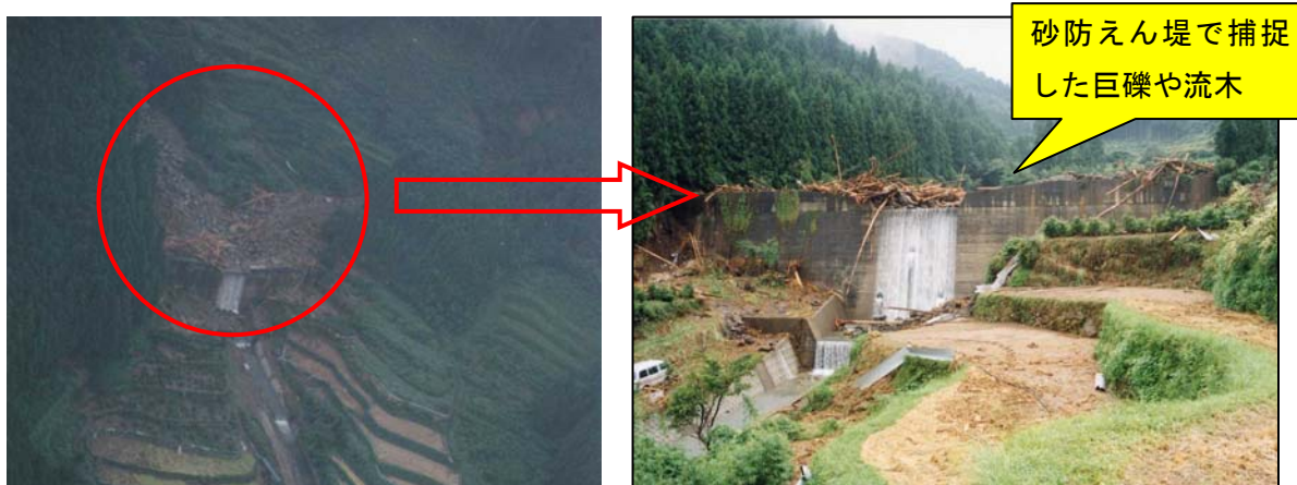
写真-8 土石流を捕捉した成谷えん堤
