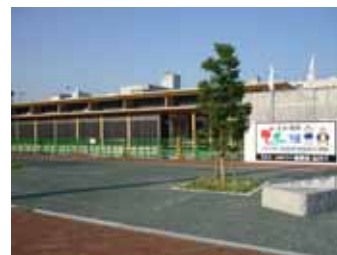
パビリオン（建設中）
