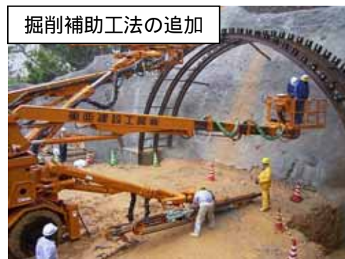
掘削補助工法の一例（長尺先受工法）
