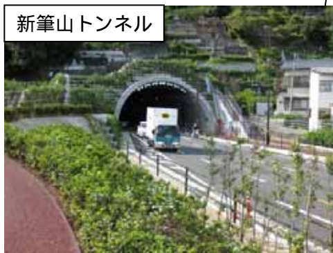
新筆山トンネル東側坑口付近 （北高見交差点より新筆山トンネルを望む）
