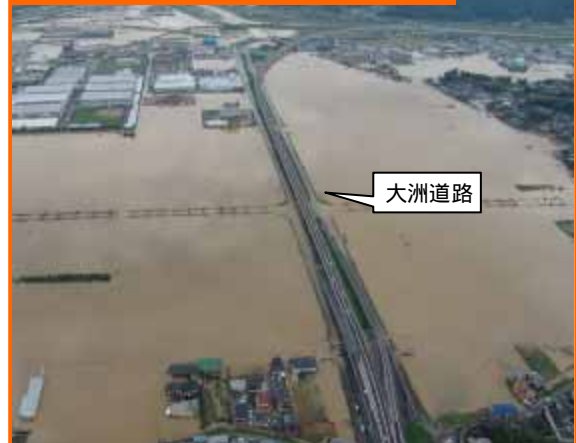
台風16号による愛媛県大洲市の浸水状況(H16.8.31)
