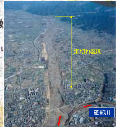
重信川 10k 付近より上流の瀬切れ状況 (H15年1月撮影)
