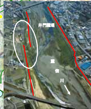
下流側上空から井門霞堤を望む
