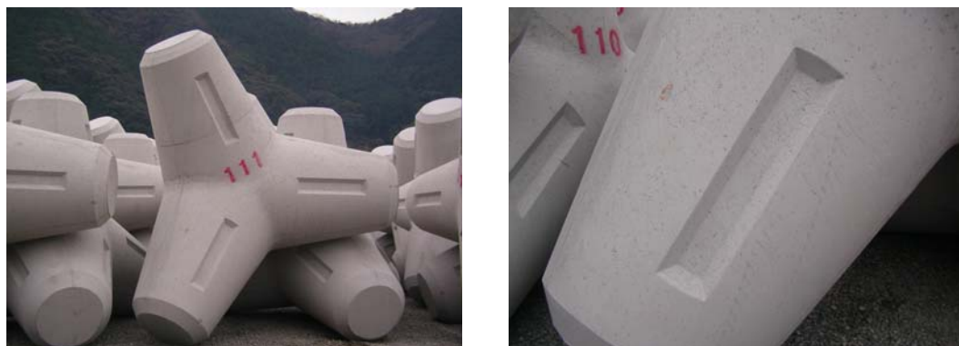
須崎港防波堤に使用する溝付きの消波ブロック
