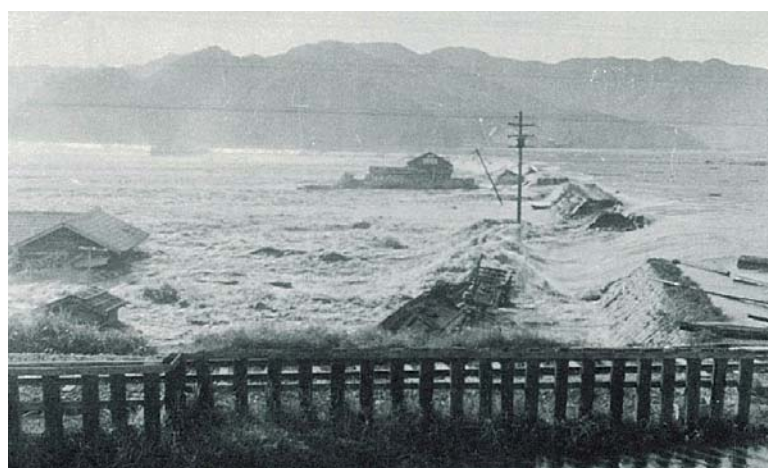
チリ地震津波被害状況(昭和 35 年)
