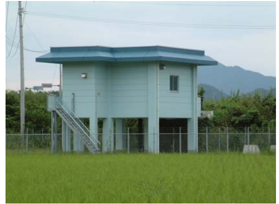
水道取水施設
