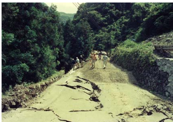
県道の被災状況
