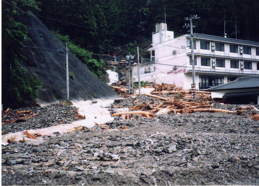
土石流による建物・県道の被災状況
