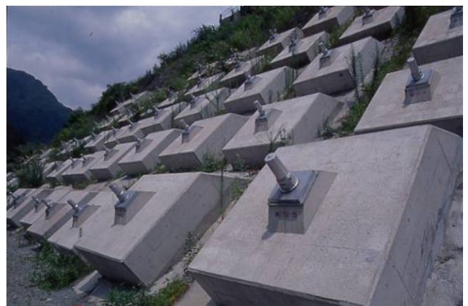
抑止工写真；アンカー工（Z-1ブロック）
