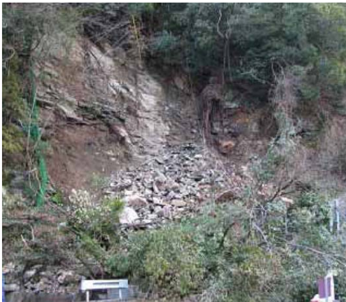
県道上の崩壊状況
