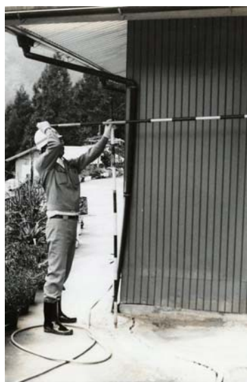
人家の変形状況
