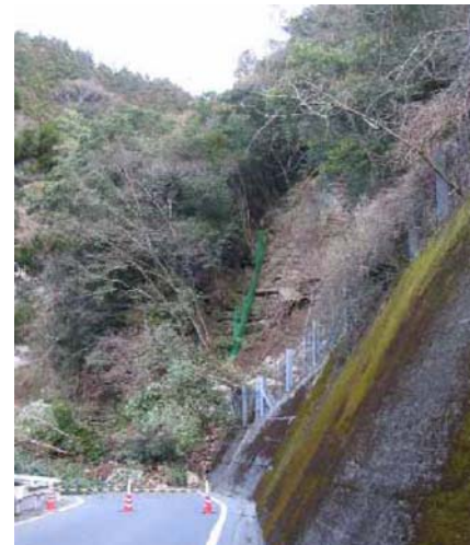
県道の埋没状況
