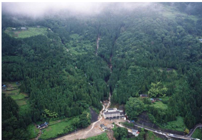
土石流災害箇所の全景
