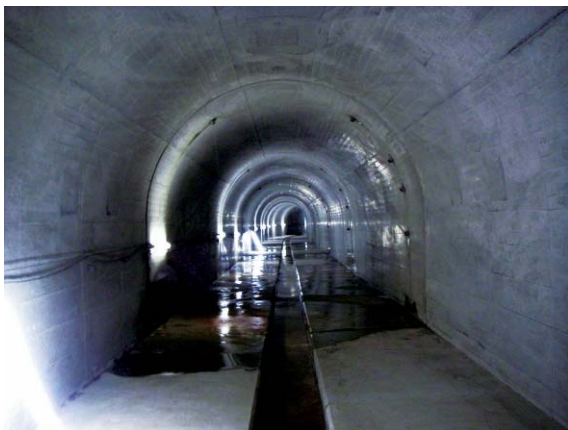
抑制工写真：排水トンネル（Z-2ブロック）
