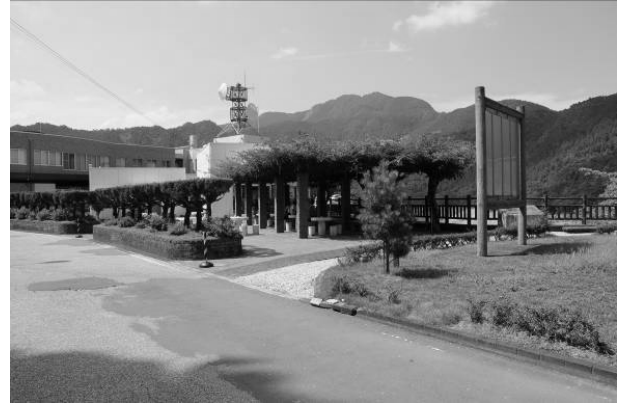
ダムサイト右岸地区
