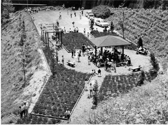
ダムサイト右岸地区
