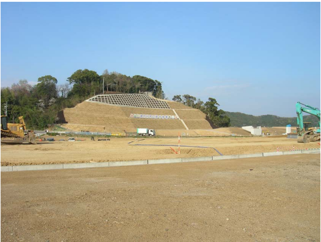
图 2.6 波介川河口導流事業 工事实施状況
