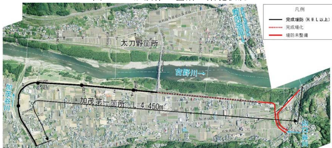
図2.2.7 加茂第一箇所箇所の築堤状況
