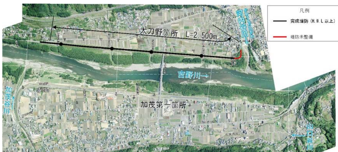
図2.1.7 太刀野箇所の築堤状況
