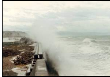
南国工区仁井田地先越波状況 (昭和54年台風16号)
