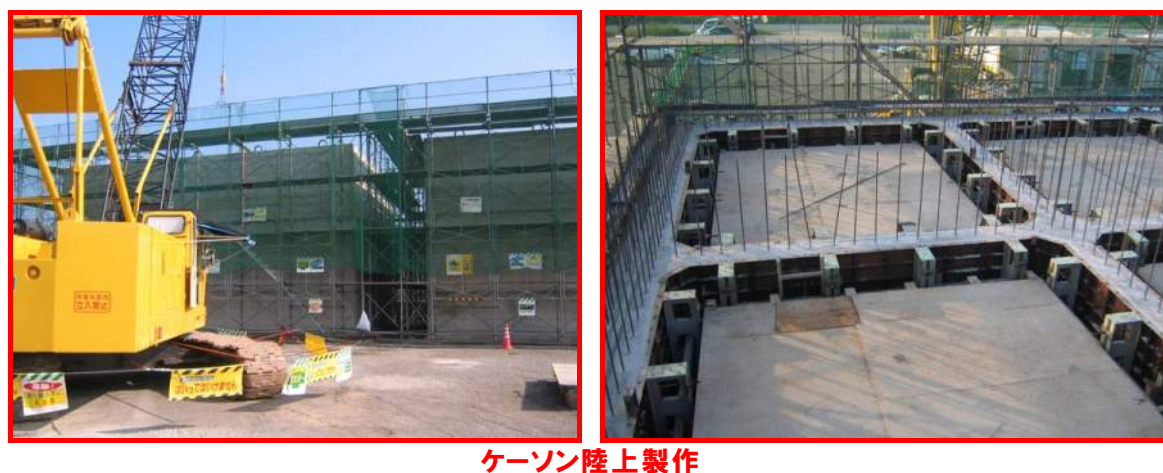
写真－ 5.1 ケーソンFD製作およびケーソン陸上作成状況
