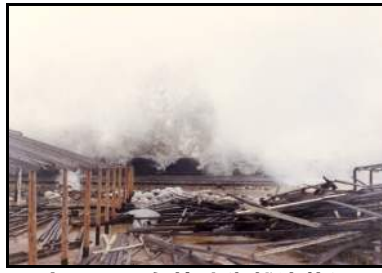
南国工区久枝地先越波状況 (昭和49年台風14,16号)
