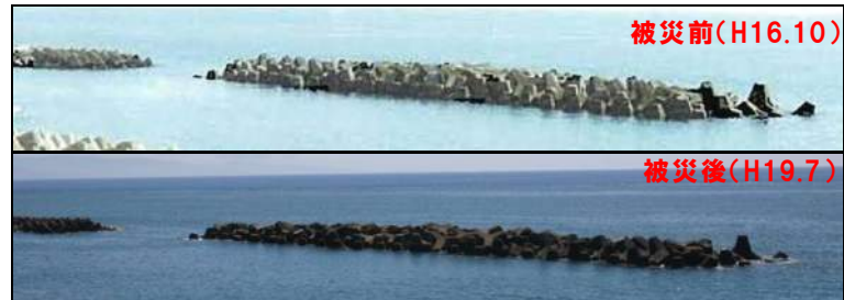
南国市十市地先離岸堤被災状況 (平成19年台風4号)
