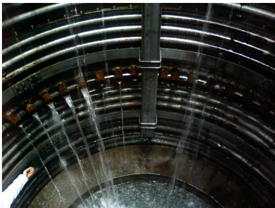
抑制工写真：集水井工（怒田N-2ブロック）
