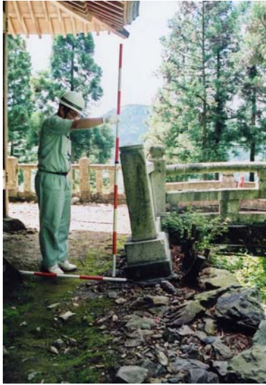
神社玉垣の被災状況
