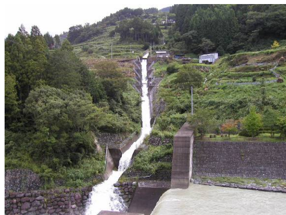
抑制工写真；表面排水路工（怒田N-2ブロック）
