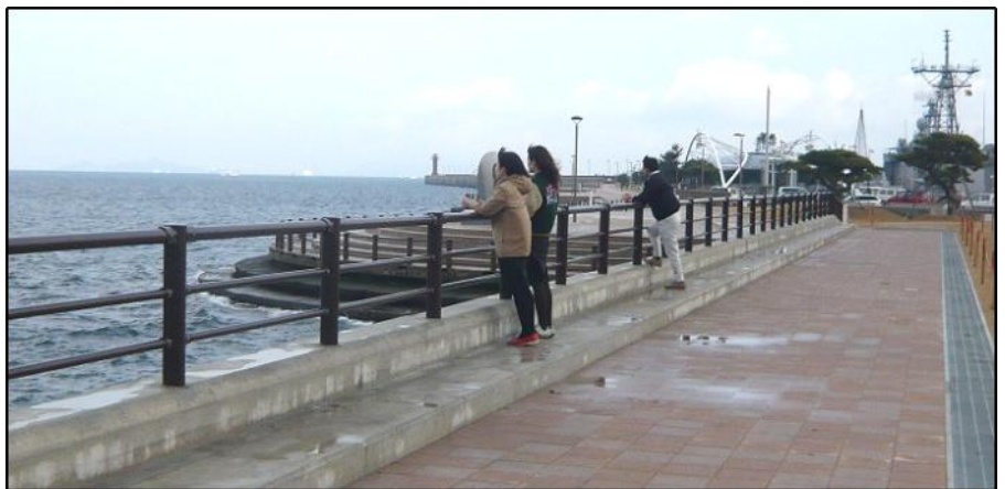
サンポート工区：平成19年11月撮影
