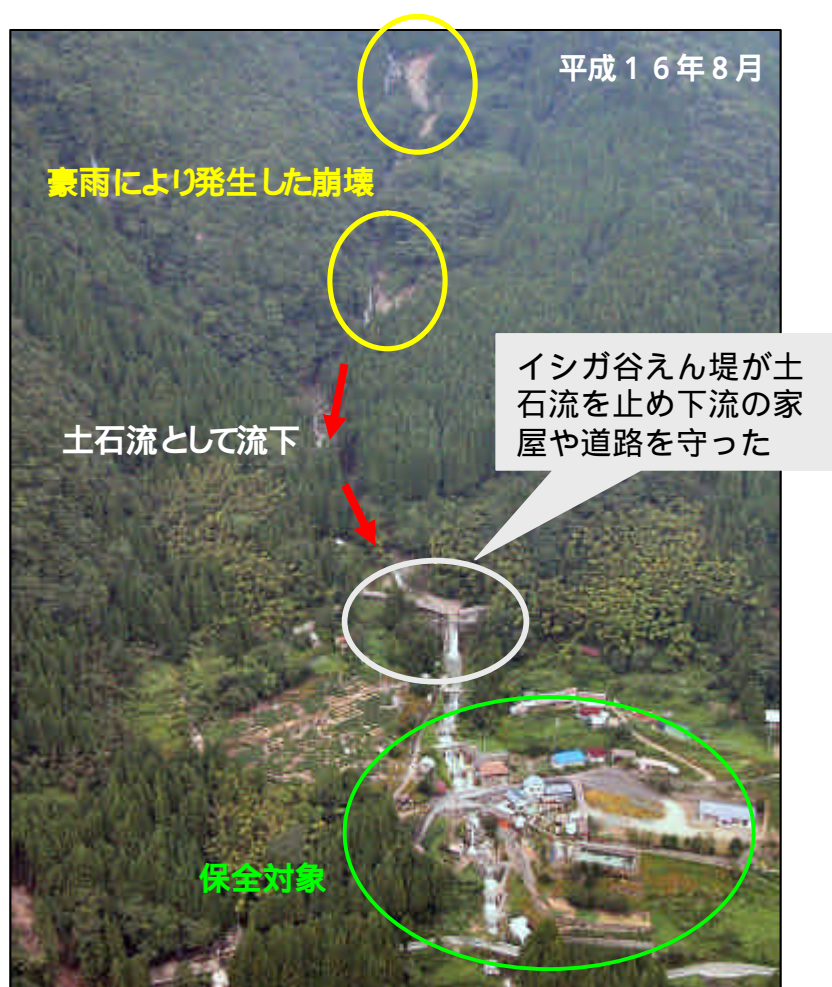
写真-15 イシガ谷えん堤 高知県土佐町
