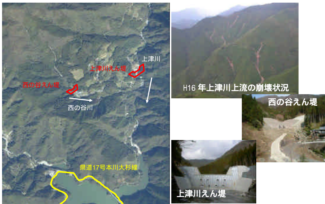
写真-6 上津川えん堤と西の谷えん堤
