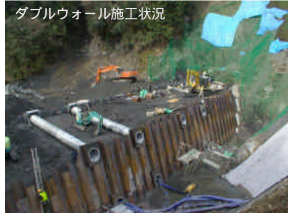
(b) ダブルウォール工法を採用した上津川 こうづがわ えん堤
