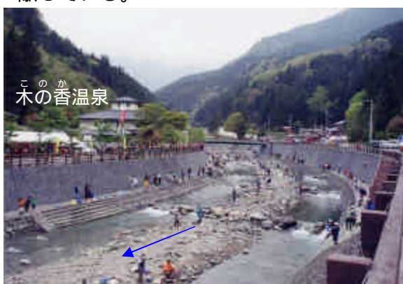
写真-18 桑瀬床固工群
