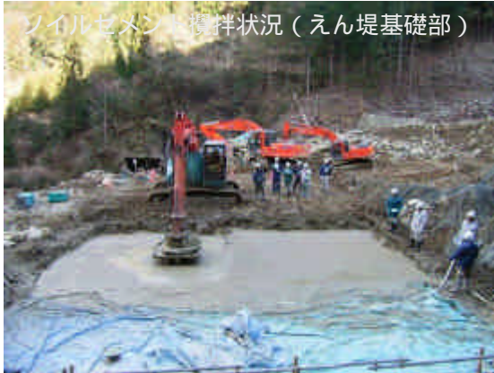
(a) 砂防ソイルセメント工法を採用した井口 いくちがわ えん堤
