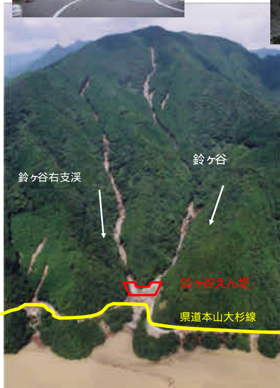
写真-8 鈴ヶ谷えん堤
