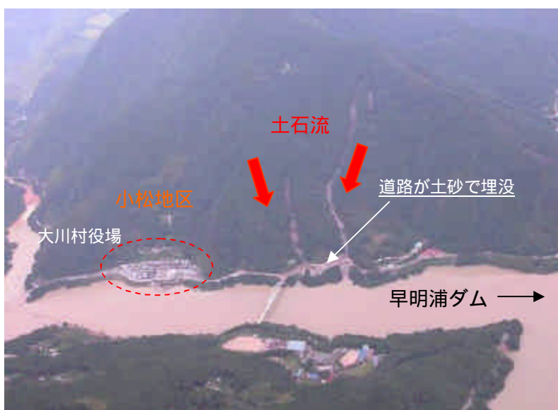
写真-16 平成16年8月台風15号豪雨により大川橋下流で発生した土石流と小松地区
