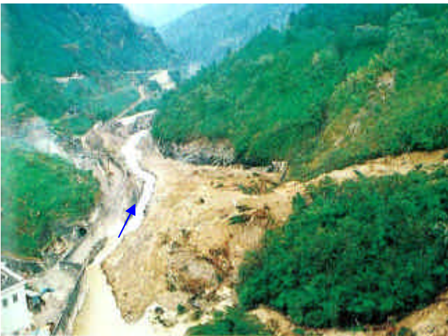
写真-14 昭和51年台風17号による被害 長沢ダム下流(いの町)*1
