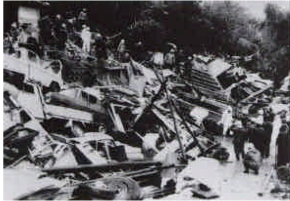
写真-13 昭和49年9月 台風18号による土石流被害(土佐町)
