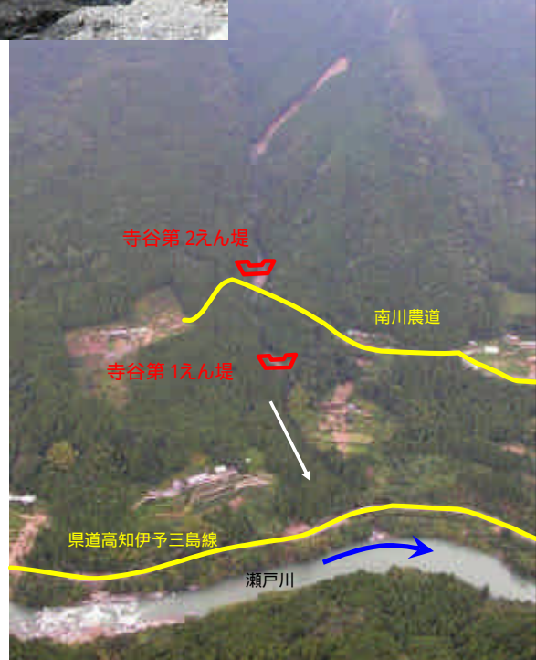
写真-9 寺谷えん堤
