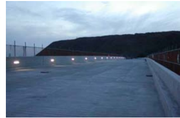
壁高欄に埋め込んだ照明の点灯試験
