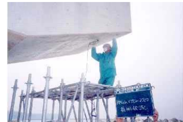
橋脚の粗面仕上げ状況
