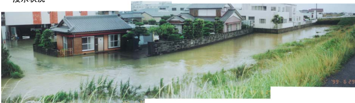
④桑野川左岸(阿南市宝田町川原地区)の浸水状況
