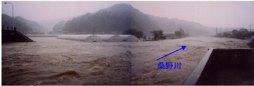
①桑野川上流(阿南市新野町秋山地区)の越水状況
