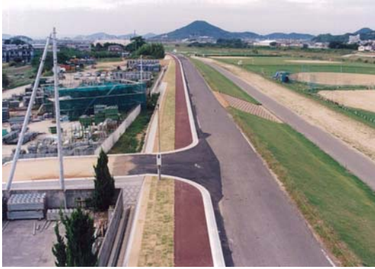
法面の緩傾斜盛土による護岸緑化
