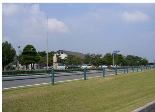
ガードパイプ
