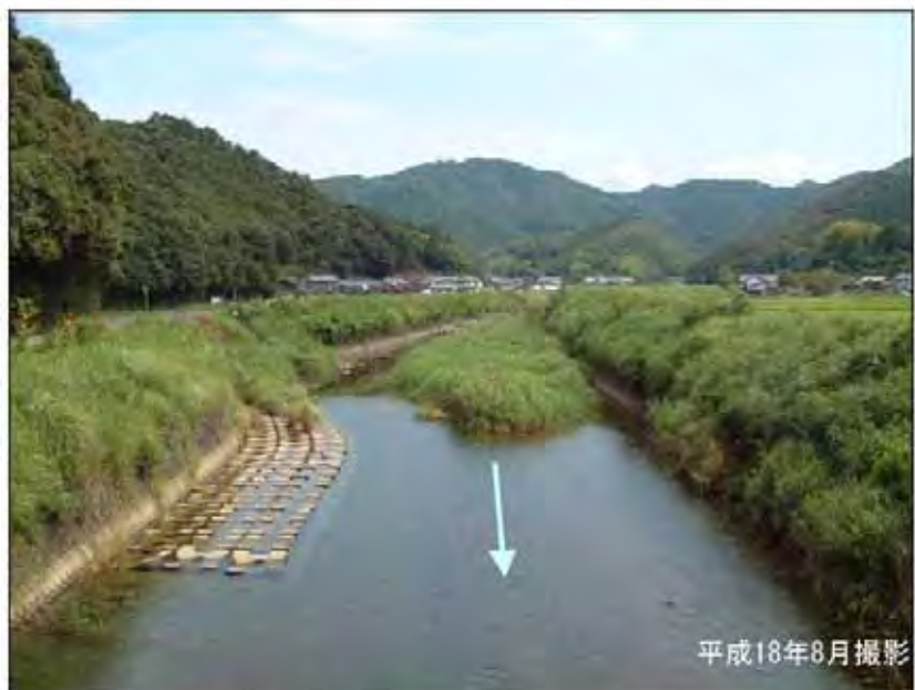
平常時の横瀬川 ヒエダロ橋付近
