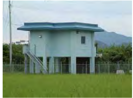
水道取水施設
